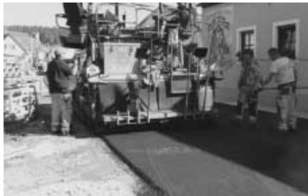
Asphaltierungsarbeiten in Krachenhausen
